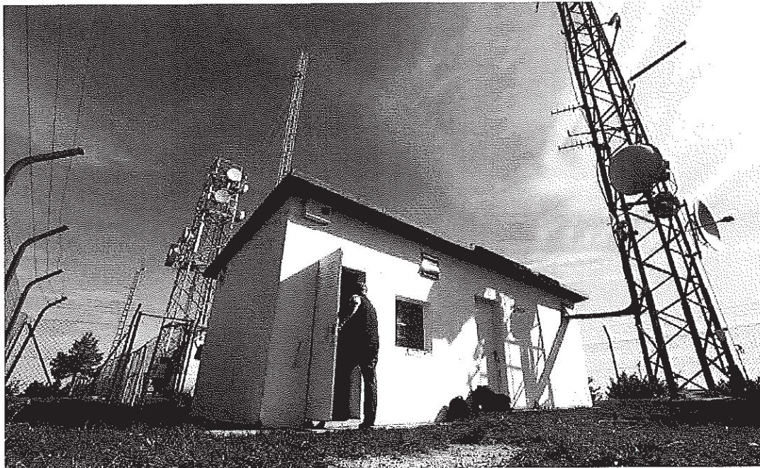
El pasado mayo, un operario entra en una caseta en el Perdón, desde donde ETB emitía su señal a la comarca de Pamplona sin autorización. EFE
